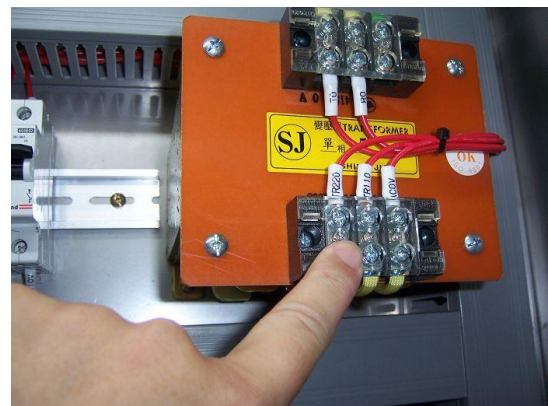
(樣板) 變壓器 IP2X 防手觸電
